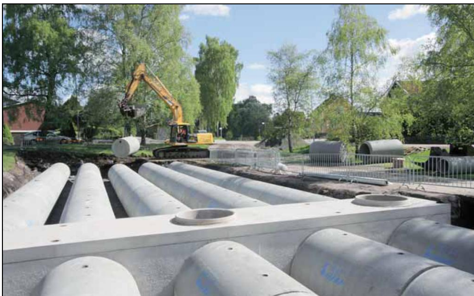
Figur 2. Exempel på utjämningsmagasin (Alfarör), i betong
